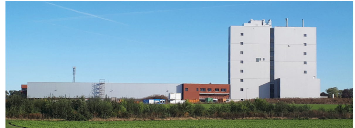
↑ Usine de traitement d'avoine avec ligne de granulation en Allemagne
