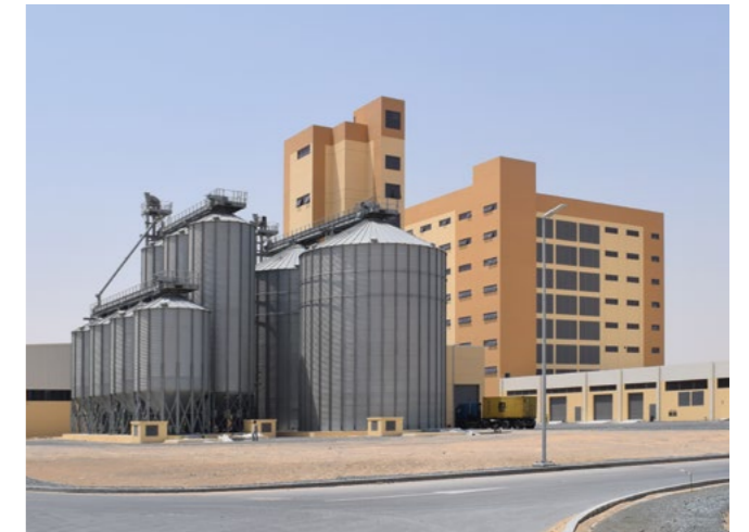
↑ Mischfutteranlage: Durchsatzleistung bis zu 245.000 t/a
