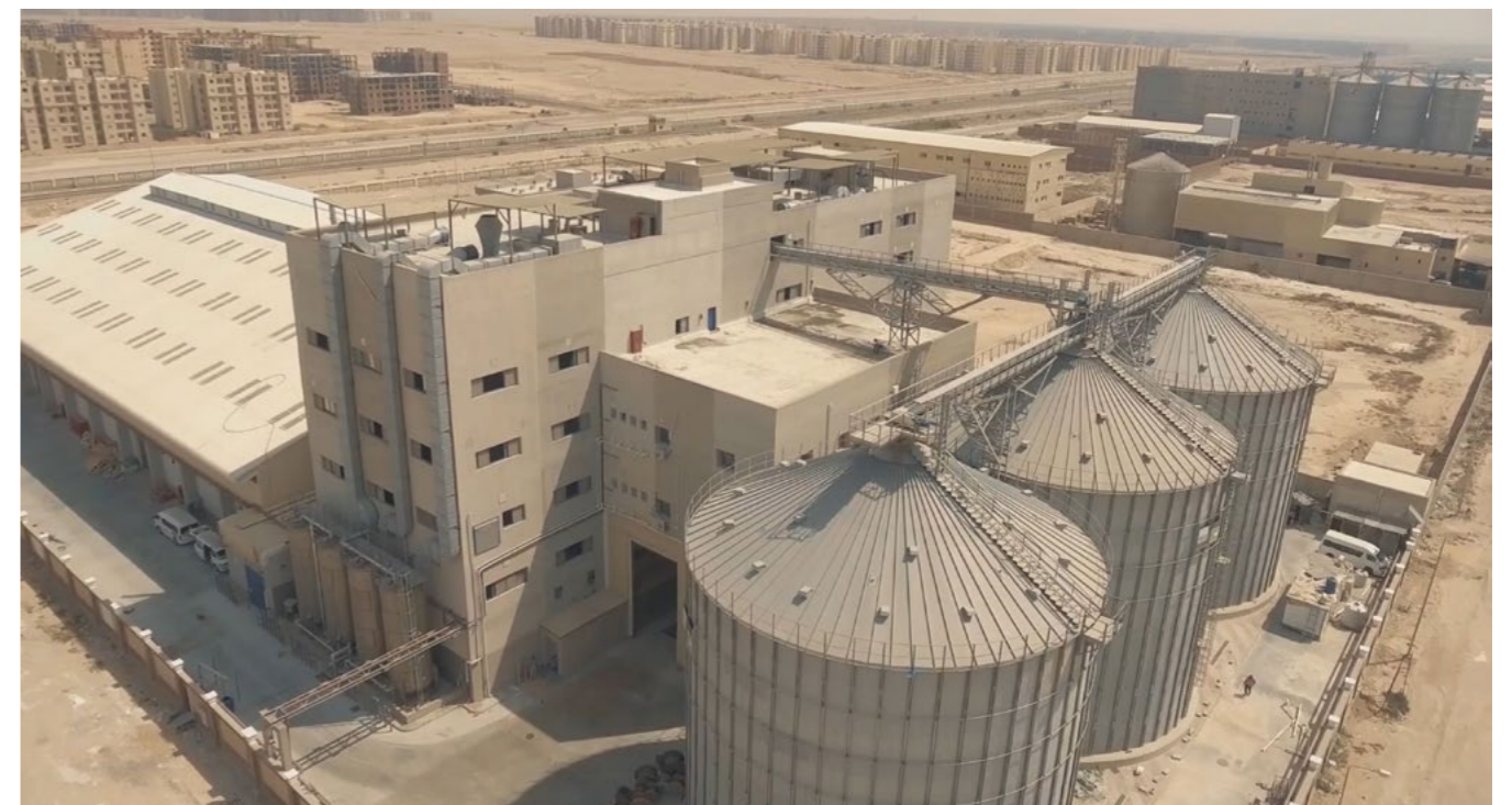
↑ Mischfutteranlage: Durchsatzleistung bis zu 210.000 t/a
